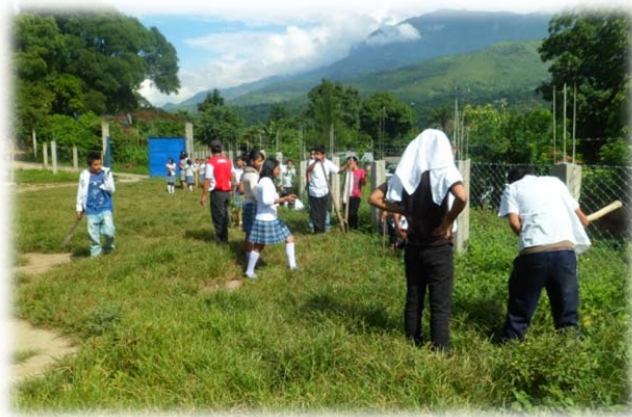
Imagen 8. Realizando Limpieza del terreno y agujeros.
