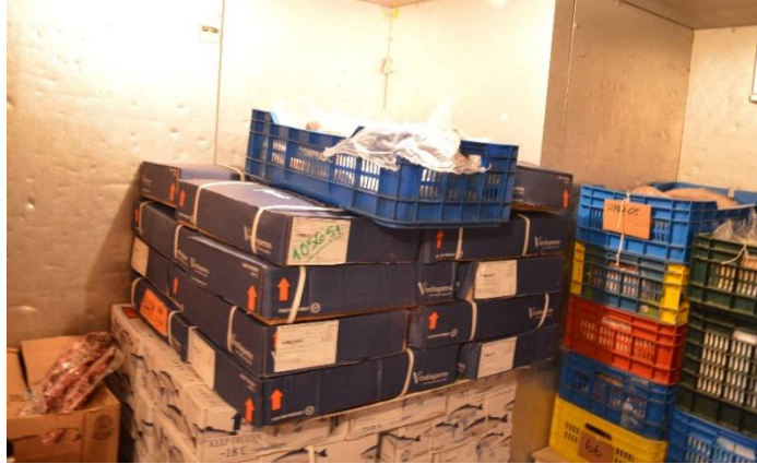
Figura 10. Interior de cuarto frío de carnes
