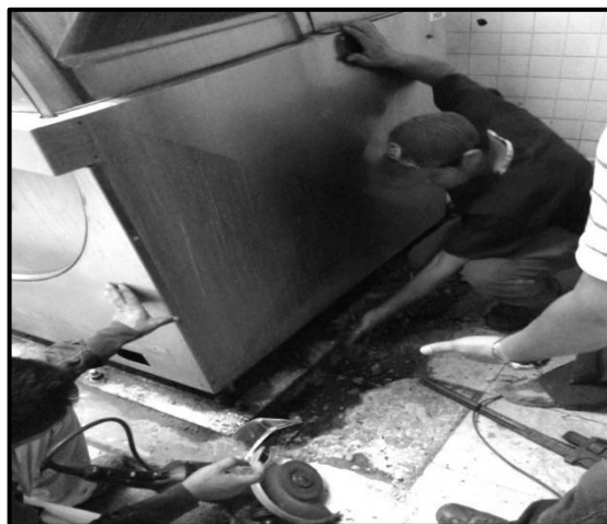
Figura 19. Vista de trabajos de reparación de anclaje
