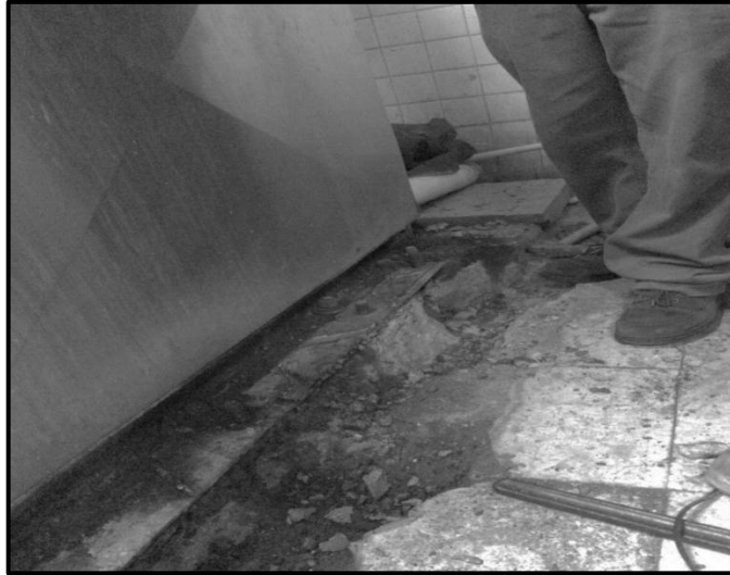
Figura 20. Vista de trabajos de reparación a base de lavadora
