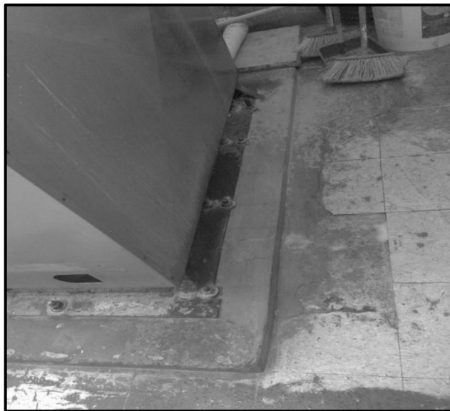
Figura 21. Vista de trabajo terminado en anclaje de lavadora
