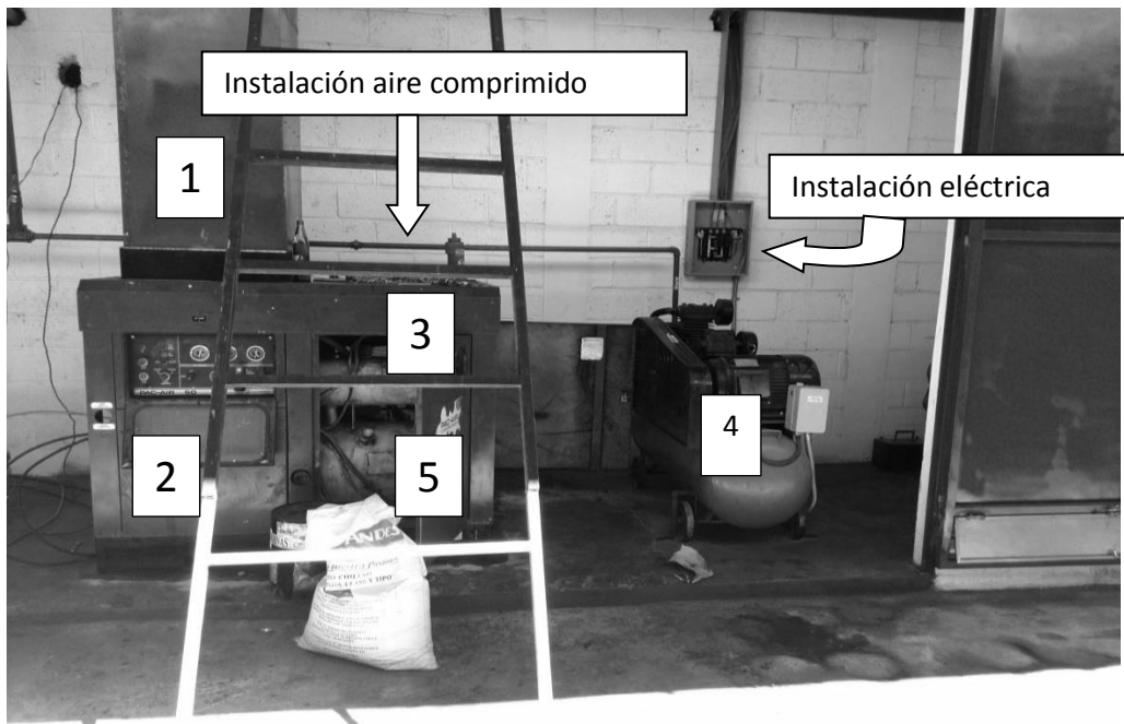
Figura 42. Partes de sistema de aire comprimido de empresa dedicada a accesorios y carnadas de pesca
