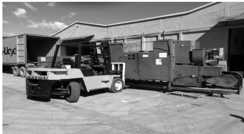
Figura 26. Manipulación de equipos con montacargas.
