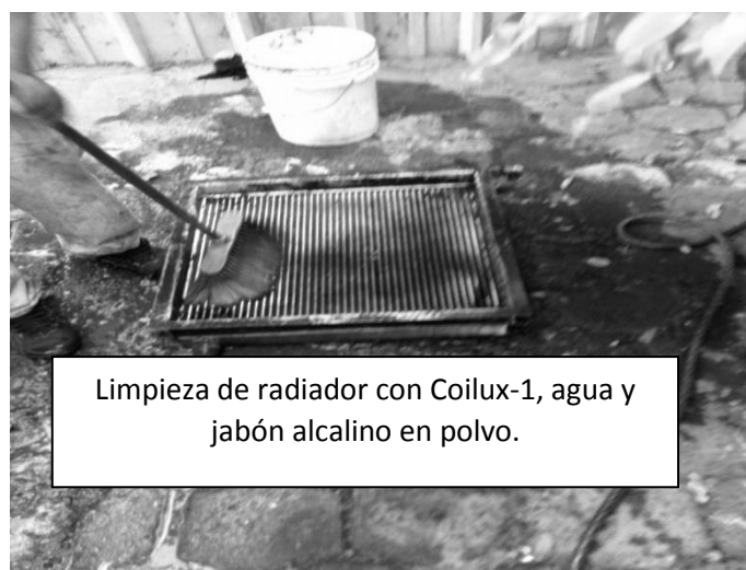
Figura 35. Lavado de radiador de compresor
