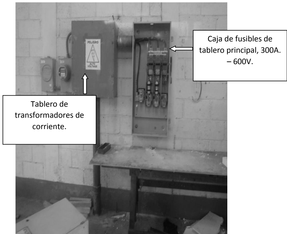
Figura 58. Instalación de tablero principal
