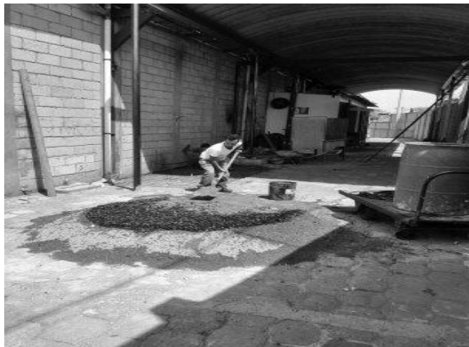
Figura 27. Preparación de concreto para nivelación de piso en la planta
