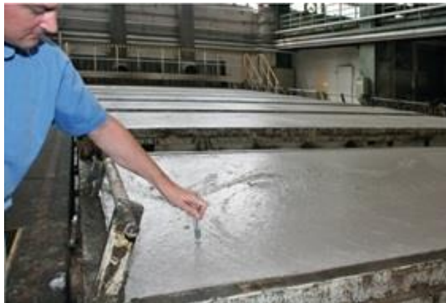
Figura 10. Chequeo de endurecimiento de la mezcla
