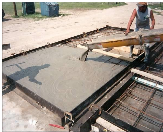
Figura 6. Panel prefabricado de concreto celular
