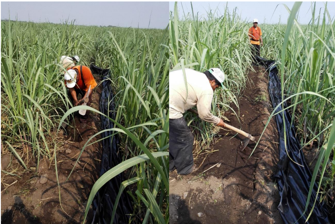
Figura 17. Instalación de canal conductor.
