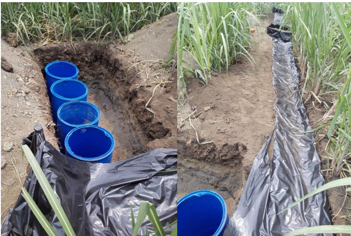
Figura 18. Instalación del sistema colector.
