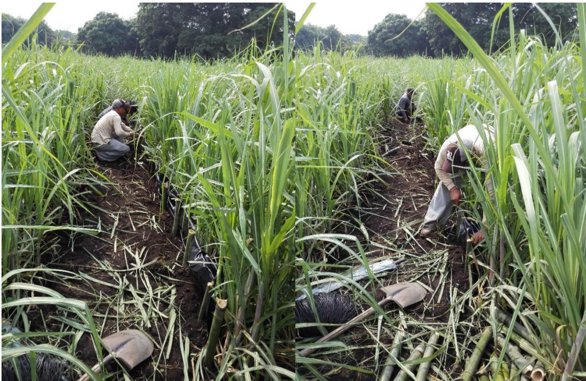
Figura 15. Instalación de parcelas de escorrentía.
