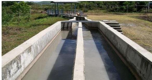
**Figura No. 5** Desarenador del sistema de tratamiento.
