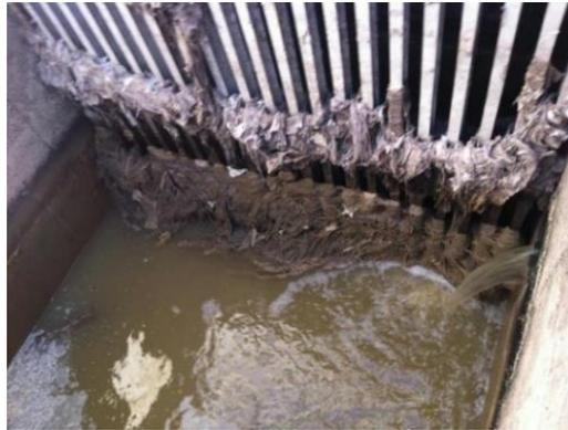
**Figura No. 4** Rejillas del sistema de tratamiento.
