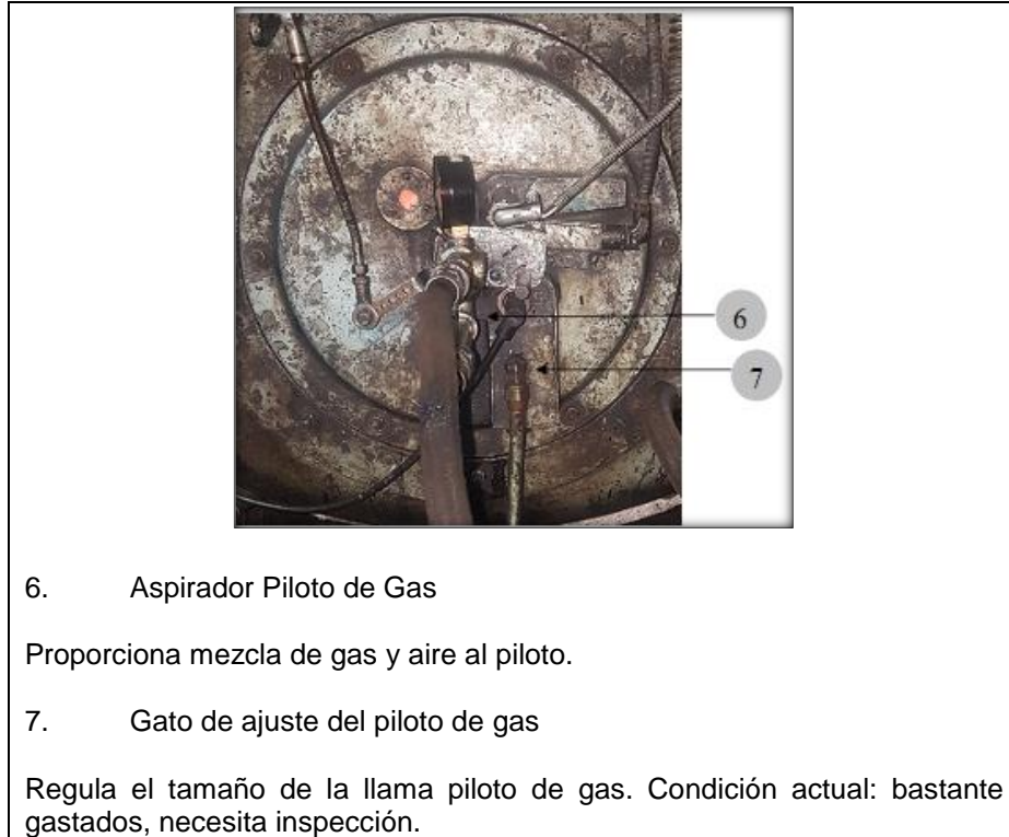
Figura 11. Inyector de gas a caldera
