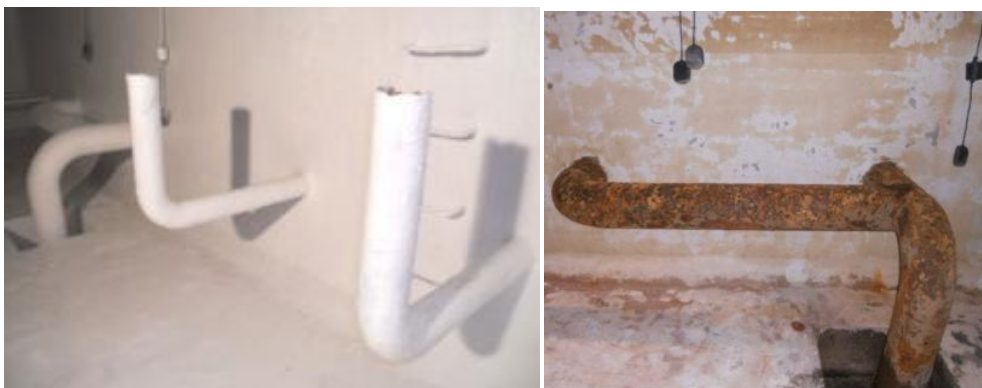
Figura 55. Impermeabilizante de cisterna
