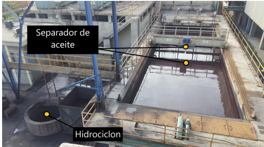
Figura 83. Separador de aceite y sólidos
