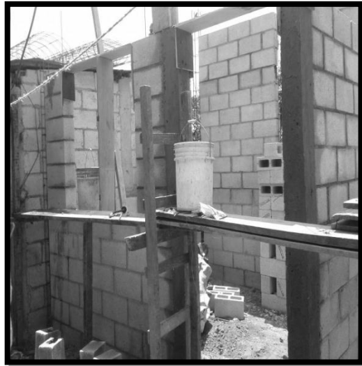
Figura 15. Avance de la unidad habitacional
