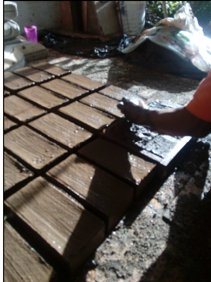
Figura 15. Fabricación de muestras de ladrillos
