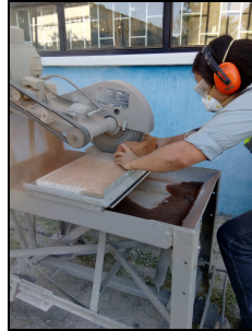
Figura 20. Corte de ladrillos
