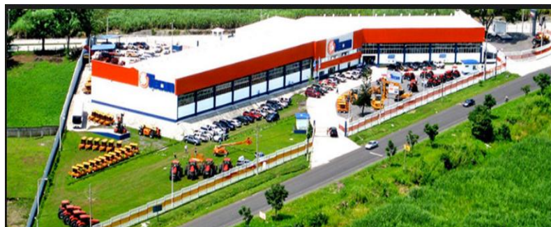
Figura 1. Centro de servicio
