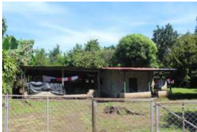
Figura 23. Casa con techo de lámina
