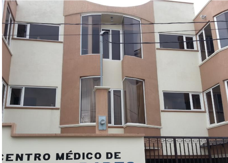
Figura 22. Acometida eléctrica empotrada en media tensión 13,8 kV
