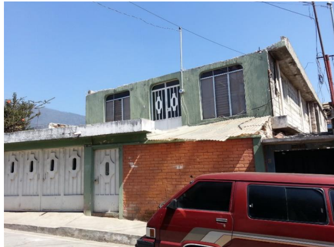
Figura 19. Acometida eléctrica de difícil acceso
