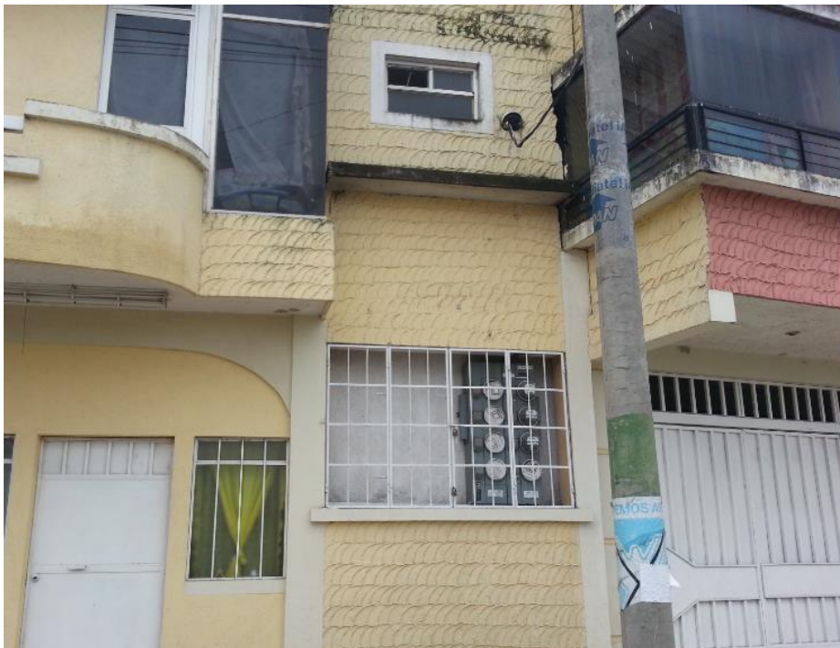
Figura 20. Acometida eléctrica comerciales
